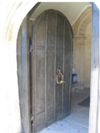
Exterior porch door
