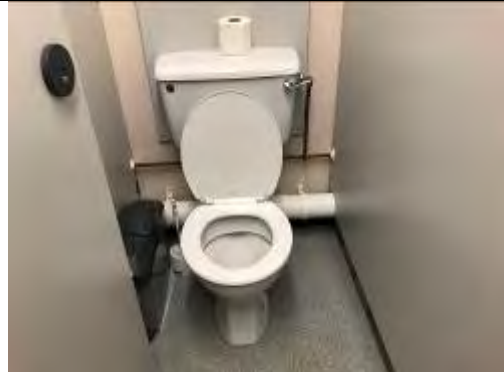
Modern non ACM toilet suite
