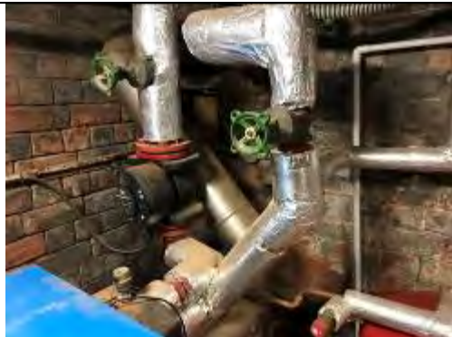
Modern non ACM MMMF foil wrapped pipe lagging
